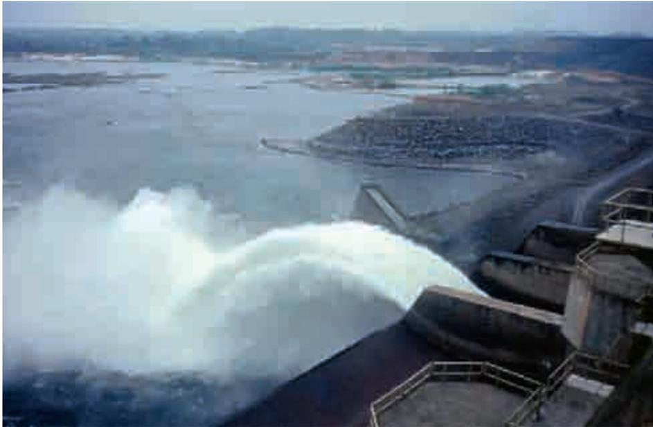
**Figura 1. Vertedouro da barragem de Tucuruí, no rio Tocantins, Estado do Pará. Água sai do reservatório a uma profundidade de 20 m, onde carrega grandes quantidades de metano. A pulverização em gotículas libera este gás de efeito estufa para a atmosfera, contribuindo para o aquecimento global (Fotografia por Philip M. Fearnside).**
