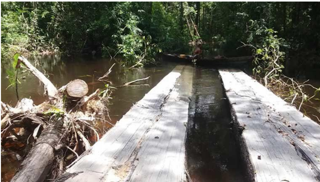
Ponte feita de tronco partido de castanheira, parte do ramal ilegal sendo construído na Reserva Extrativista do Lago do Capanã Grande. Imagem cortesia de cacique que preferiu manter anonimato.
