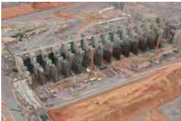
Vista Jusante - Vertedouro Principal
