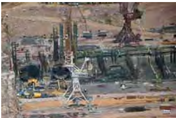
Casa de Força
