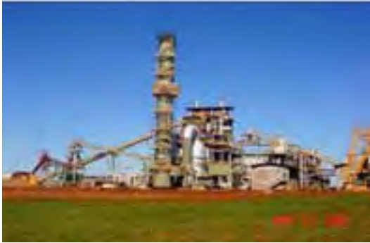
Vista geral da usina
