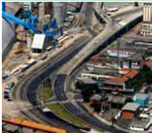
Vista aérea do viaduto
