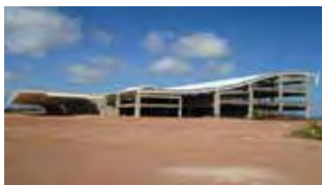
Construção novo Terminal de Passageiros
