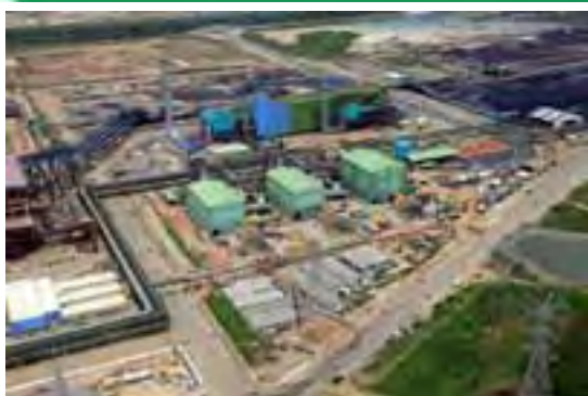
Vista Aérea do Empreendimento
