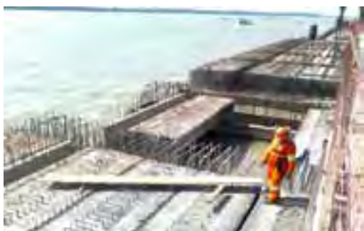
Construção do Berço 100
