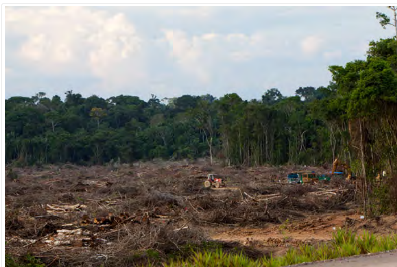
Desmatamento em área a ser alagada pela usina de Jirau Foto: Marcelo Min
