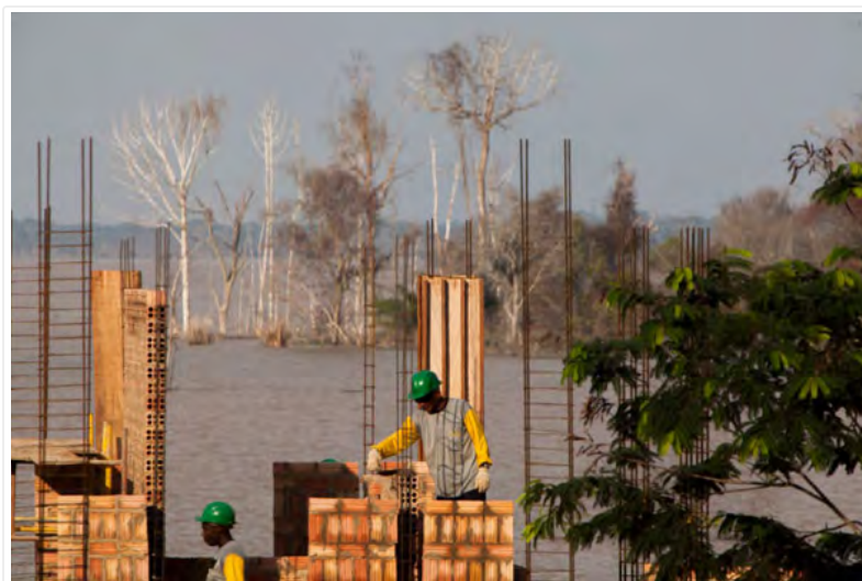
Obra da usina de Santo Antônio em vila que foi removida. Ao fundo, árvores mortas devido ao alagamento Foto: Marcelo Min
