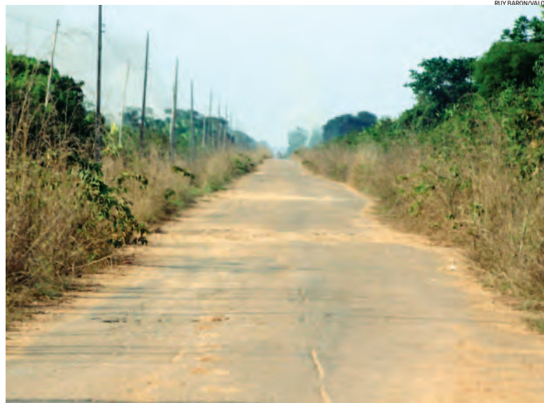
Cabos de fibra óptica na BR-319: operadora mantém condições mínimas de tráfego para fazer a manutenção da rede
