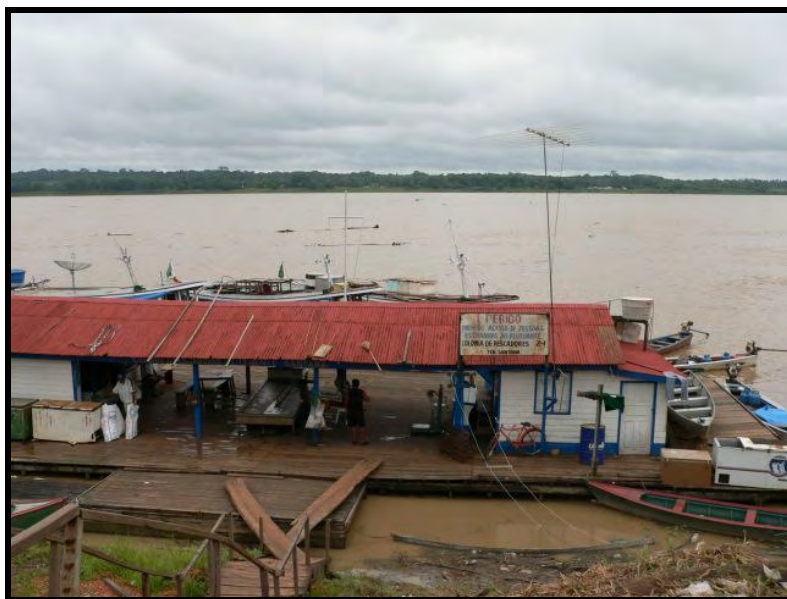
FOTO B.IV. 114 – Ponto de desembarque flutuante do Cai n'água, Porto Velho/RO.
