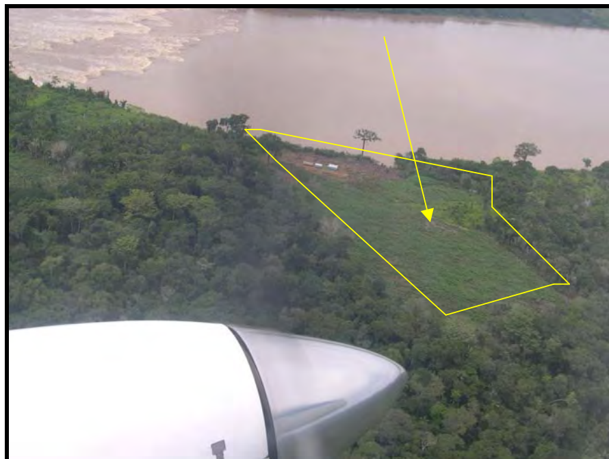
FOTO B.IV. 150 – Vista aérea de ocupação ribeirinha (seta) na margem direita do rio Madeira
