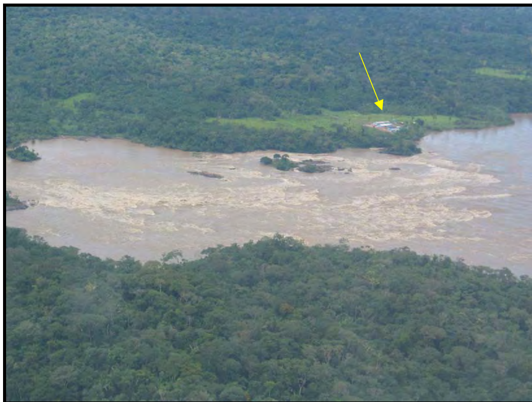
FOTO B.IV. 163 – Salto do Jirau no rio Madeira onde se observa o acampamento de Furnas Centrais Elétricas (seta)
